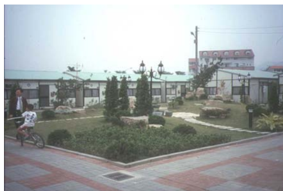
図 - 台湾、南投県大愛一村（仮設住宅）
